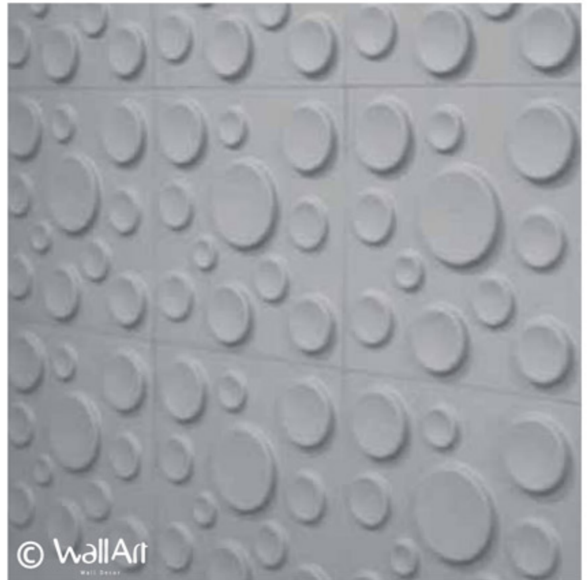
Rezultat postavljenih 3D panela sa vidnim spojnicama.
